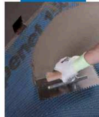
Stesura di Mape-net 150 su Mapenet 150
