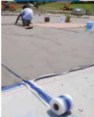
Impermeabilizzazione dei massetti con Mapelastic e Mapeband
