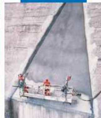
Esempio di applicazione a spruzzo di Mapelastic in una dia
