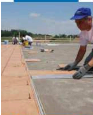
Posa di ceramica con Kerabond + Isolastic
