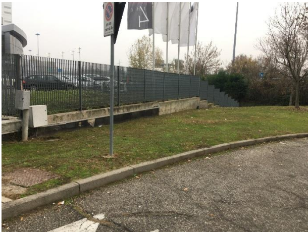
R.F.17: Vista del muro di confine tra BMW Milano e l'attigua area verde.
