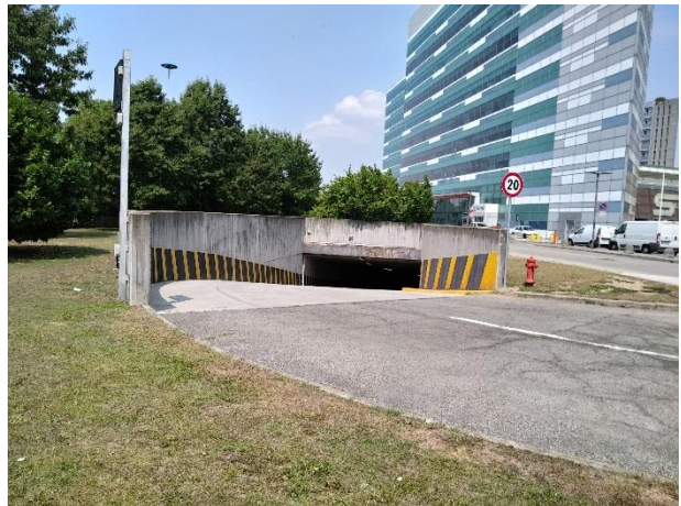
R.F.12: Vista di dettaglio della rampa di ingresso/uscita dalla autorimessa interrata sud-est.
