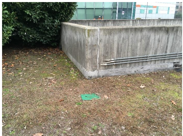
R.F.26: Possibile punto di consegna nuove utenze acqua potabile ed energia elettrica
