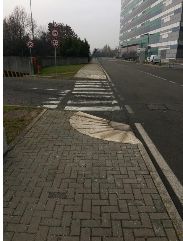
R.F.28: Segnaletica in corrispondenza della rampa di ingresso/uscita dalla autorimessa interrata sud-est da ripristinare e integrare nella nuova segnaletica orizzontale
