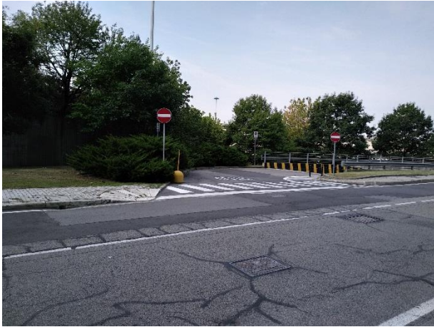
R.F.03: Area di uscita dall'autorimessa interrata posta a nord-ovest.
