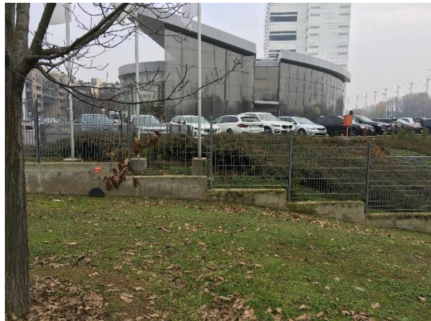
R.F.18: Vista dettaglio muro ad altezza variabile in avvicinamento al muro di confine del Raccordo autostradale di Piazzale Corvetto.
