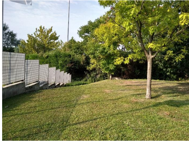
R.F.16: Vista di dettaglio del degradare della attuale quota della pavimentazione a verde.
