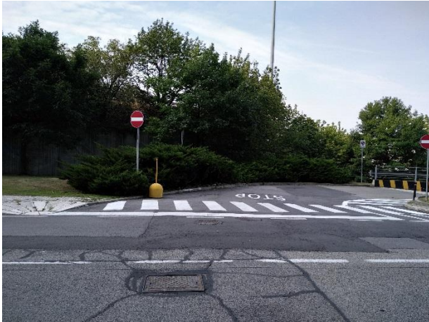
R.F.27: Segnaletica in corrispondenza della rampa di uscita dalla autorimessa interrata nord-ovest da ripristinare e integrare nella nuova segnaletica orizzontale
